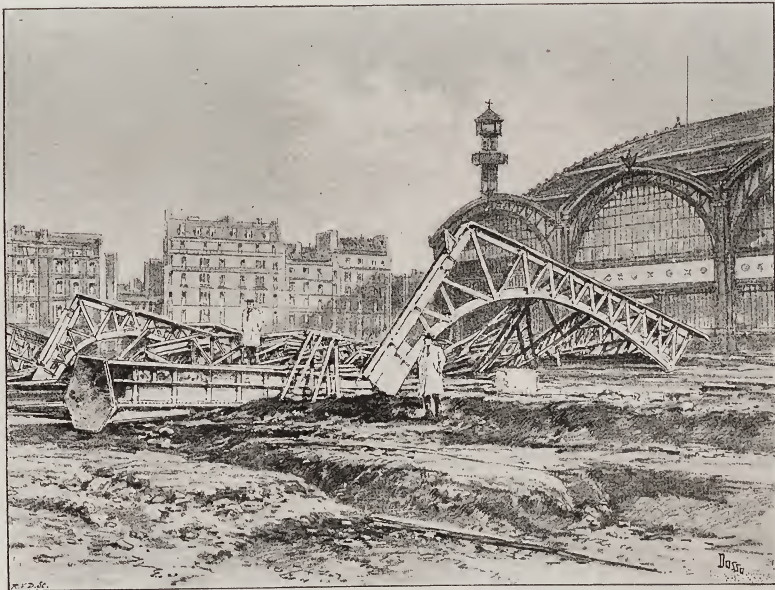
AU CHAMP-DE-MARS. — Effondrement de la galerie de 30 mètres.
